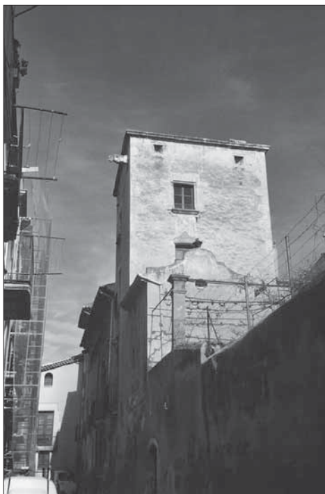
Torre de la casa del Prado. El Vendrell
